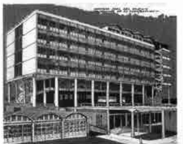
Perspectiva del Centro Cívico al término de su construcción. Memorias del ministro de Obras Públicas. © Ilustrada en el libro El movimiento moderno en Barranquilla. 1946-1964 . Carlos Bell Lemus. Universidad del Atlántico. Barranquilla, 2002.
