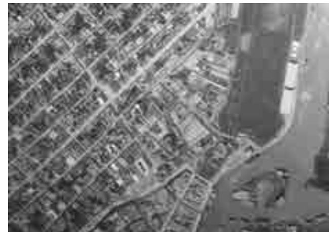
Fotografía aérea del lugar de construcción del Centro Cívico en 1937, casi una década antes de iniciar las obras. © Instituto Geográfico Agustín Codazzi.
