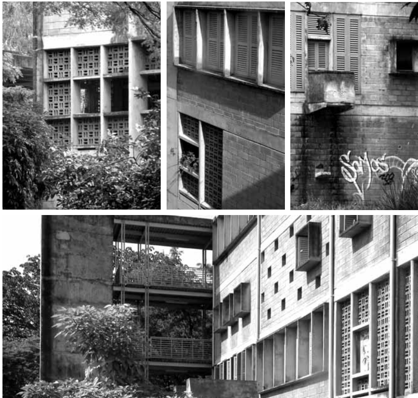
Figuras 10, 11, 12 y 13. Diferentes aspectos de los cerramientos, con bloques calados, póstigos con persianas y parasoles
