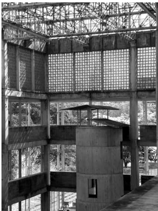
Figura 8. El vestíbulo inconcluso de los pasos perdidos, con la escalera cilíndrica, la estructura para el puente grúa, los corredores perimetrales y los cerramientos calados
