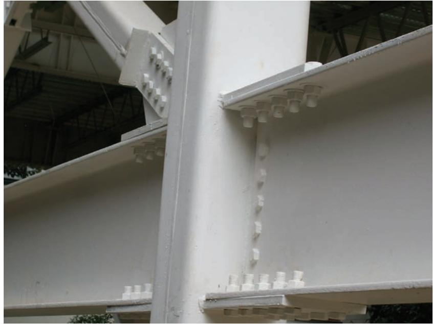
Detalles de conexiones
