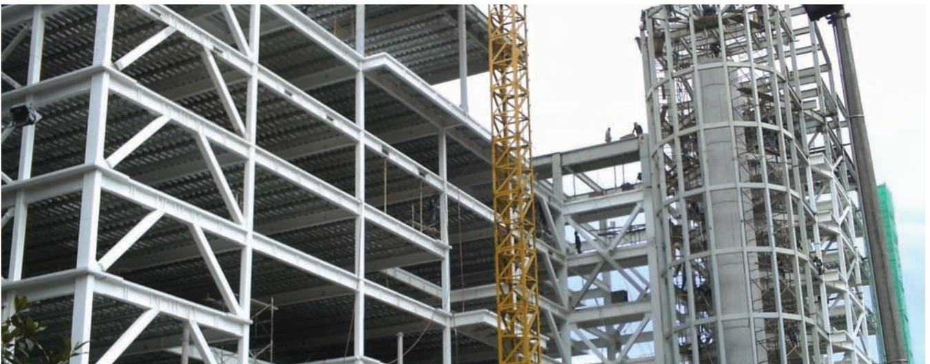
**La fachada, donde el metal es el elemento de soporte y el bloque de concreto obra como cerramiento, logró una imagen arquitectónica que armoniza con otros edificios de la universidad**
