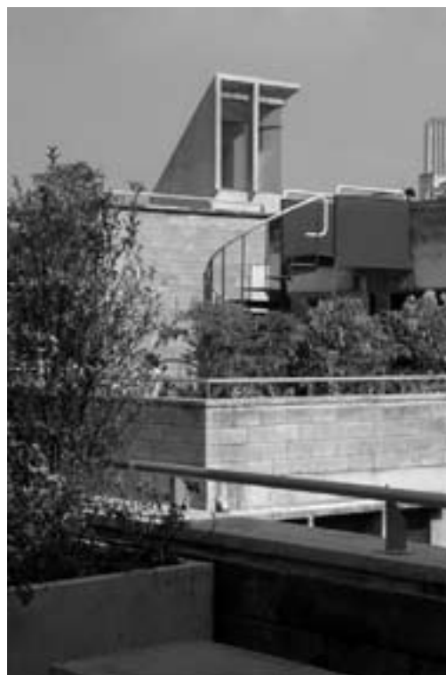
TECHOS JARDÍN DE UN EDIFICIO PARA LA UNIVERSIDAD DE LOS ANDES, PROYECTADO POR GONZALO PELÁEZ Y MAURICIO PINILLA. 1998.
