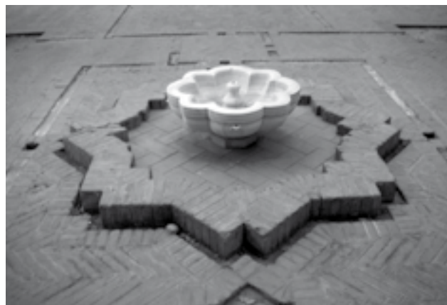
PISO DEL PATIO ANEXO A LA CATEDRAL DE SEVILLA Fotografía: Mauricio Pinilla
